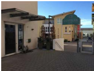
Hotel: Weg zwischen Treppe sowie Hublift und Eingang
